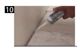
Una vez medidos y cortados los perfiles, es el momento de aplicar silicona flexible por todo el perímetro entre suelo-pared y lamas, es decir la junta de dilatación. Tras realizar esta operación, ya se pueden colocar los perfiles de aluminio.
