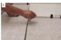
No es necesario en las instalaciones generales, pero en zonas con grandes y continuados derrames de agua es recomendable aplicar nuestro sellador Clic Seal. Éste se coloca en el mecanizado macho de la lama.
